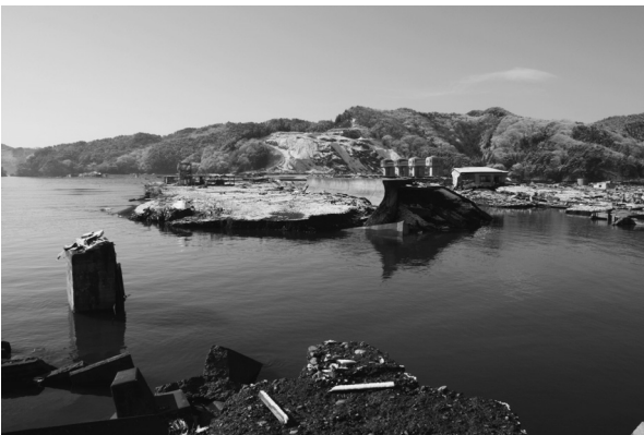
写真7. 破壊された防潮堤、陸側（右）は津波の引き潮でえぐられ、陥没して池になっている。左側の杭状のものは破壊された鉄橋の橋脚。
