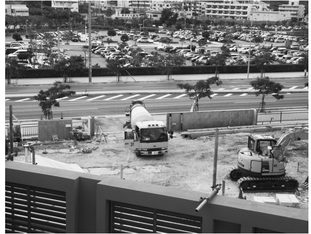
H 20. 9.30 撮影 門扉周辺工事
