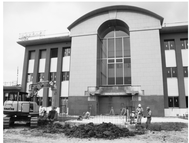
(H 20. 9.2 撮影 外構キャノピー工事)
