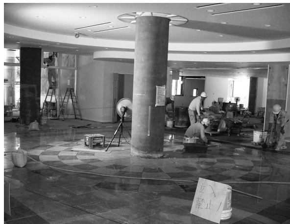
(H 20. 8.1 撮影 エントランスホール部分)
