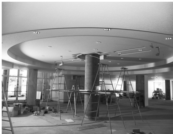
(H 20.7.8 撮影 エントランスホール部分)
