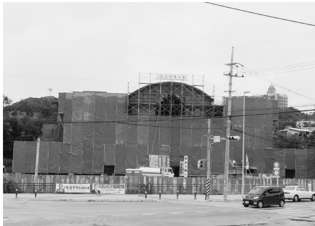
(H20.6.4日撮影 正面部分)
