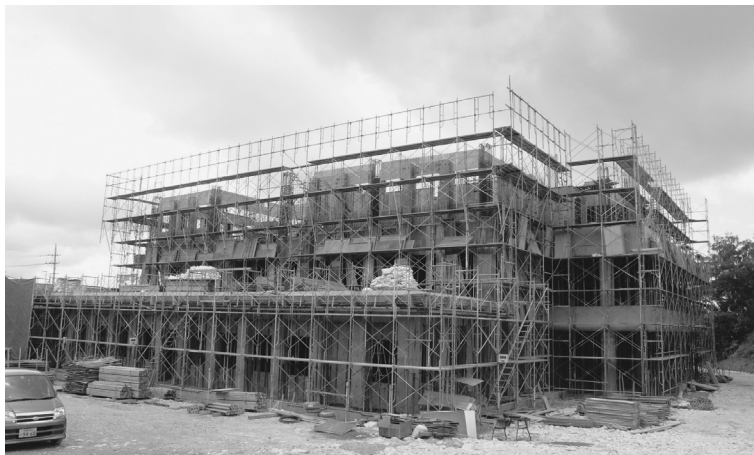
(H20.5.8日撮影 3階躯体)
