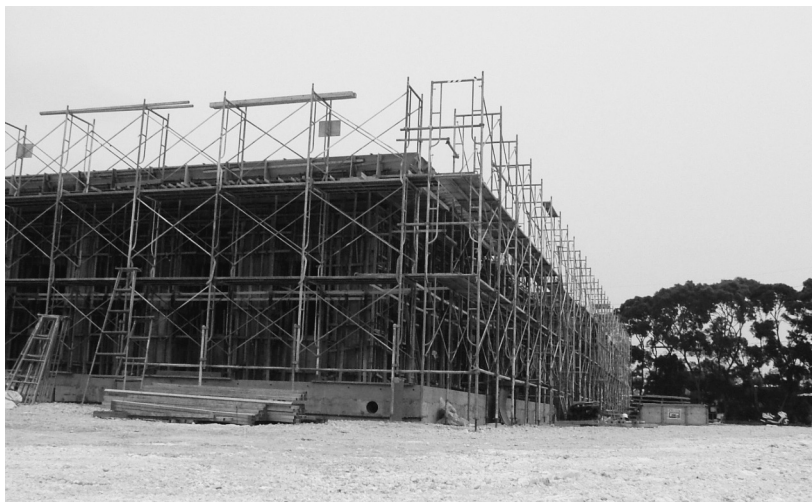
(H20.4.8日撮影 1階躯体)
