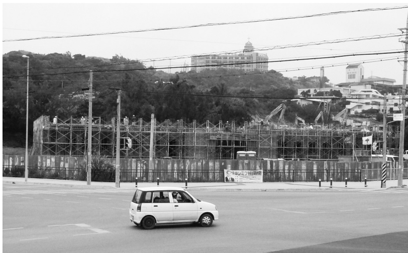
(H20.4.8日撮影 会館全景)
