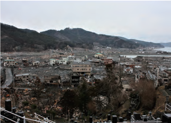
写真2 2011年3月26日撮影 大槌城跡からみた被災地。中央に見える3棟ほどの白いコンクリート製の建物と灰色の建物が被災した町役場
