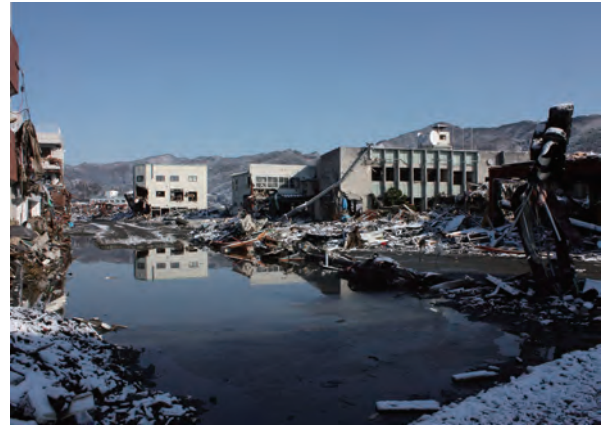
写真4 2011年3月27日撮影 震災当時の大槌町役場、役場前は津波で地面が大きくえぐられ、池のようになっている
