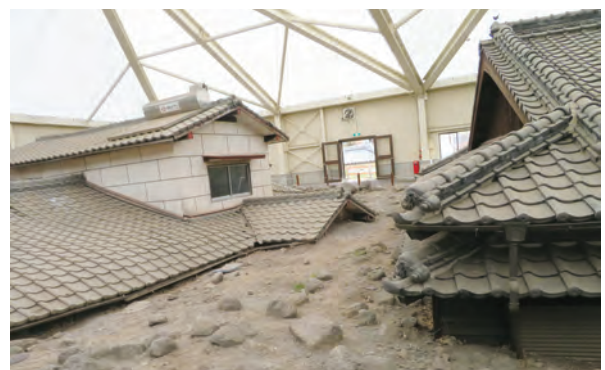
写真1 土石流で一階が完全に埋まった家屋
