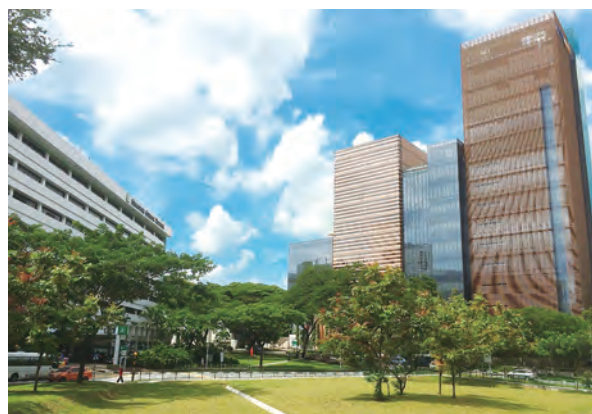
総合病院敷地内
